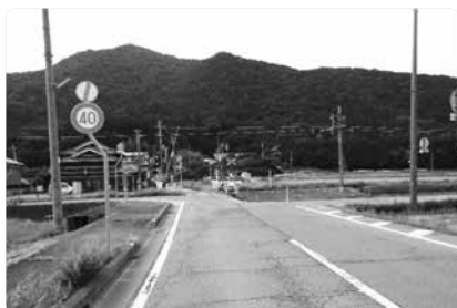
一般県道長谷市川線 澤地区
