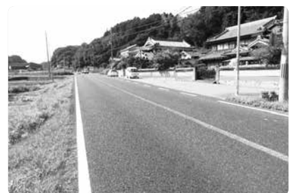
主要地方道三木穴栗線 西治地区
