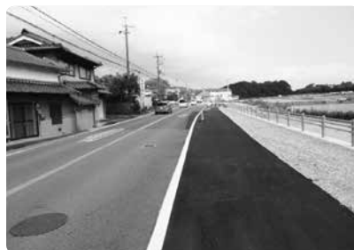
主要地方道三木穴栗線 大貫地区
