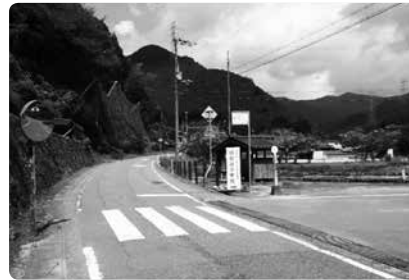
一般県道岩屋生野線 越知谷地区
